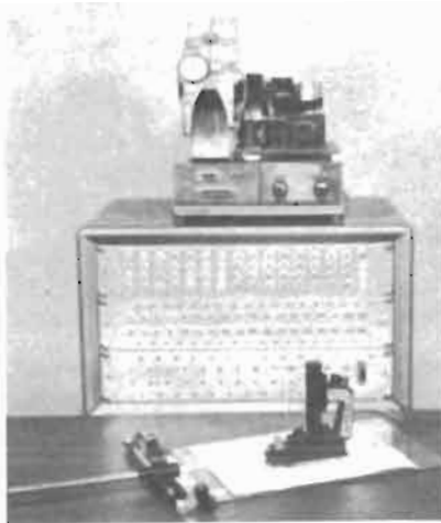
Fig. 13 - Modello sperimentale di Cognodictor con evidenziatore visivo dei caratteri identificati; sopra questo il sintetizzatore vocale a film ruotante.
